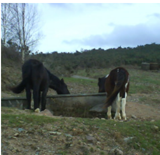
Abreuvoir relié à un captage, en extérieur.
